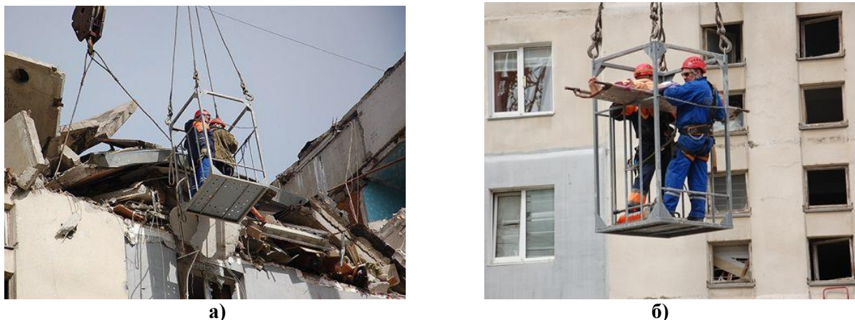
Рис. 1. Використання люльки традиційних кранів: а – видалення елементів пошкоджених будівель; б – транспортування постраждалих до землі
