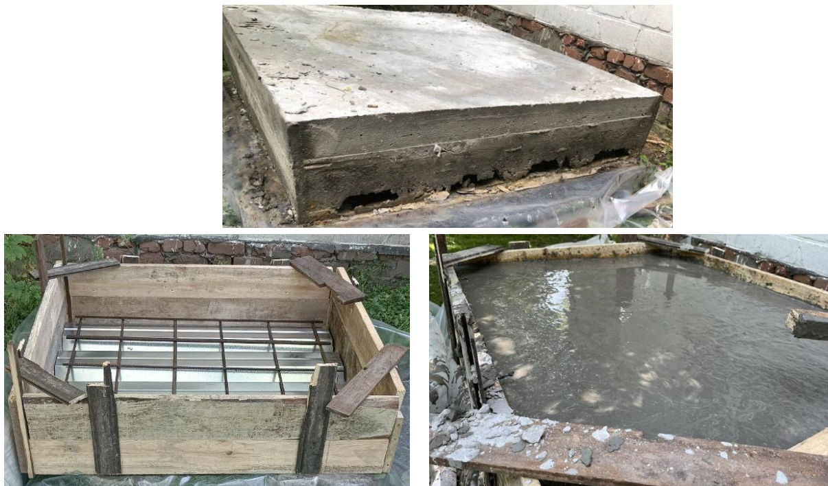
Рис. 1. Виготовлення фрагменту сталезалізобетонних плити
